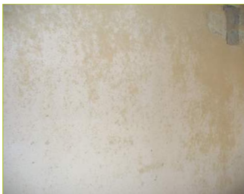
enduit de finition avec sable lavé
