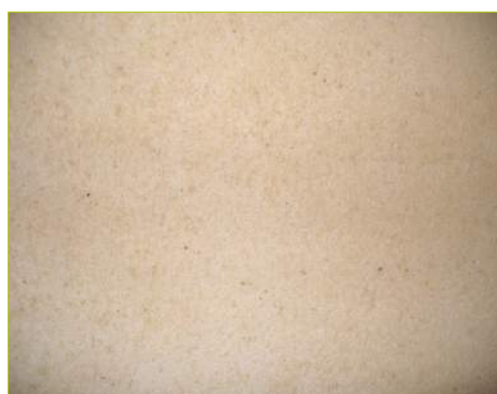
enduit de finition avec sable non lavé
