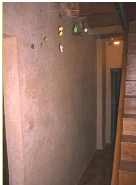
enduit de finition avec sable non lavé
