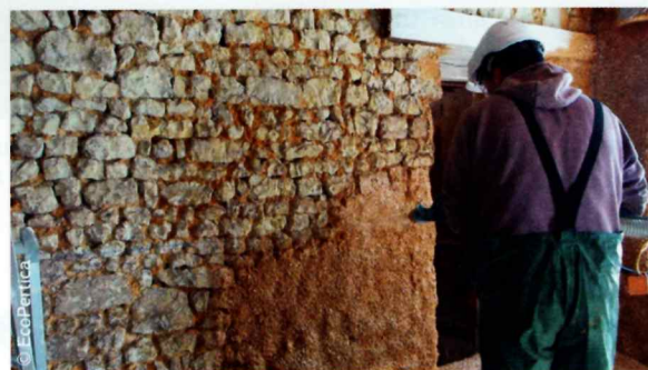
Deux centimètres d'enduit « chanvre-chaux » non recouverts représentent une alternative aux traditionnels parements « chauds » (boiseries ou tentures).
