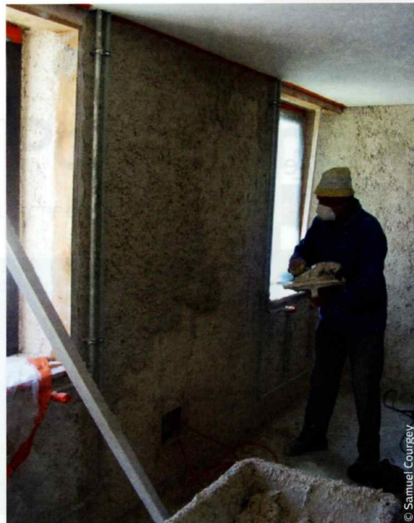
Deux centimètres d'enduit « chanvre-chaux » non recouverts représentent une alternative aux traditionnels parements « chauds » (boiseries ou tentures).
