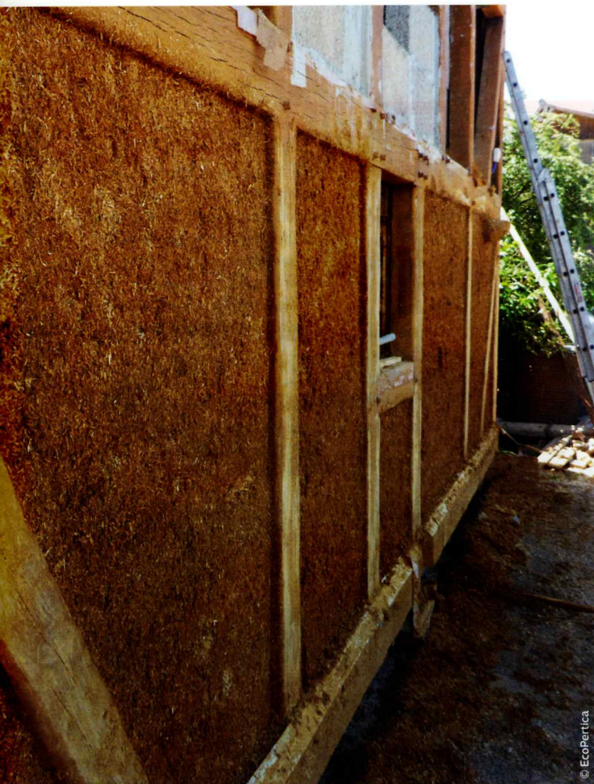
Réfection d'un colombage par projection de chanvre-terre argileuse locale.
