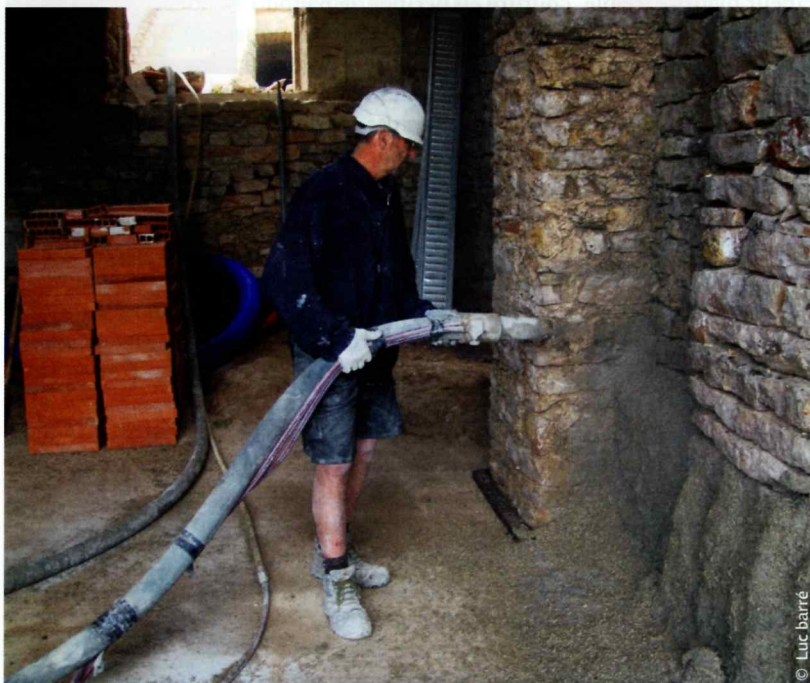
Une machine à projeter le chaux-chanvre permet des épaisseurs plus variées qu'à la main.
