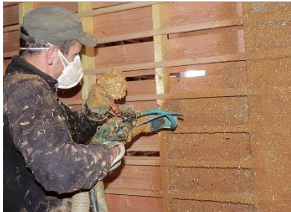
TECHNIQUE. La projeteuse terre-chanvre mise au point par Éco-Pertica permet d'enduire les murs ou de remplir les structures.
