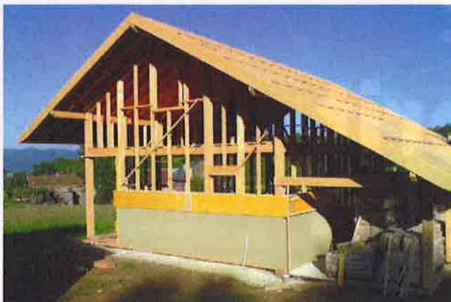
En construction neuve, le chanvre est bien adapté en complément d'une ossature bois. Le béton de chanvre, isolant, peut alors être banché (versé dans un coffrage rigide), comme ici.
